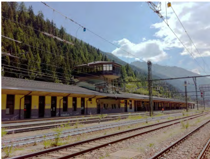
Sezionamento linea aerea e vista sulla cabina centrale di controllo traffico.
