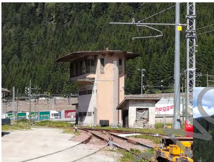
Sopra: La cabina di controllo lato austriaco non più operativa.
